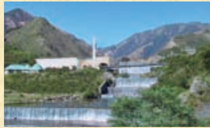
足尾砂防堰堤 荒廃した山々からの土砂流出を防ぐ目的で、昭和30年に完成。ダムの本体には、足尾焼によるカモシカの壁画が設置されている。
